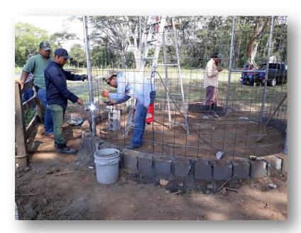
Paso 10. Colocación de la varilla de 1/2 en la parte superior como refuerzo a la malla electrosoldada.
