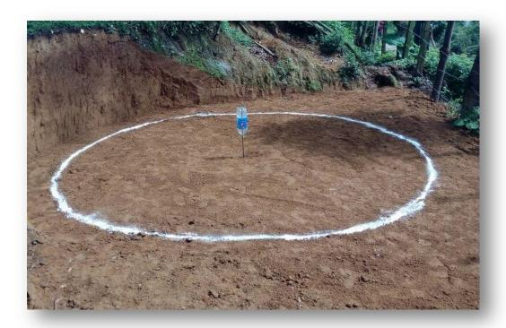
Paso 3. Apertura de zanjo para hacer el cimiento, la profundidad puede ser de 12 pulgadas y el ancho de 10 pulgadas.
