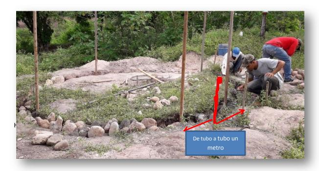
**Paso 7. Completar la fundición con piedra y concreto,** todo debe quedar a un mismo nivel, no olvidar que cada tubo debe dar la medida de 2 metros hacia el centro.
